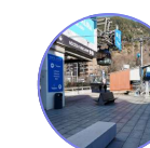
Millora de la impermeabilització de la plaça del Funicamp
