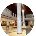
Obres de remodelació de la planta baixa de casa comuna
