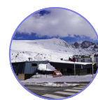
Nou espai d'oci i lleure i nova biblioteca del Pas de la Casa (antiga escola bressol)
