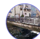
Rehabilitació del pont del riu Aixec - Av. Rouillac
