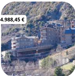
Rehabilitació del viaducte d'Hort de Godí
